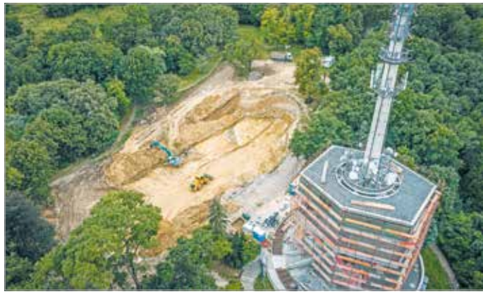
A kilátó környéki építkezés légiteléről. Fotó: Horváth Csongor
