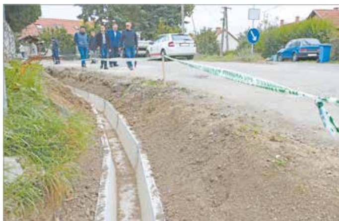
Az út mindkét oldalán mederburkoló elemekkel építették ki a már „elvadult” árkot. Fotó: Mocsári László
