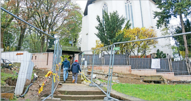
A Győri Nagy Lajos lépcsősor felső szakaszát is felújítják. Fotó: J.Á.
