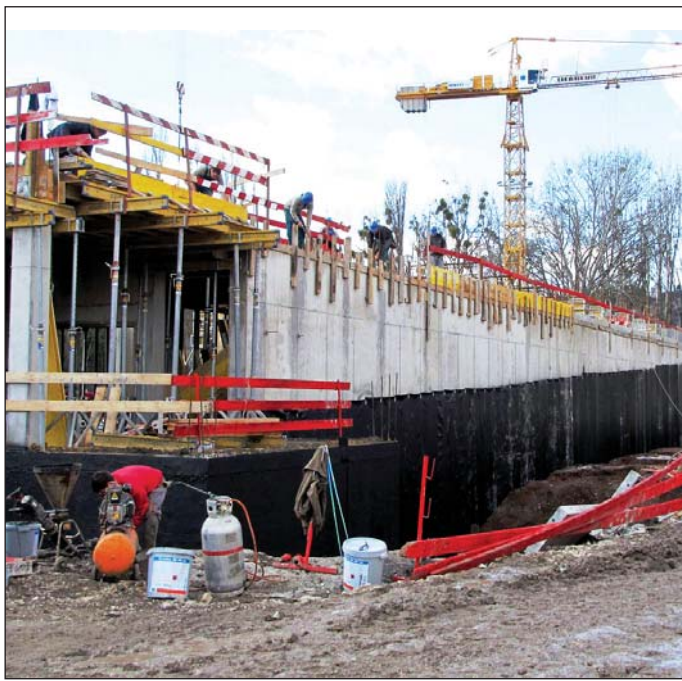
Napról napra nő ki a földből az uszoda épülete.
